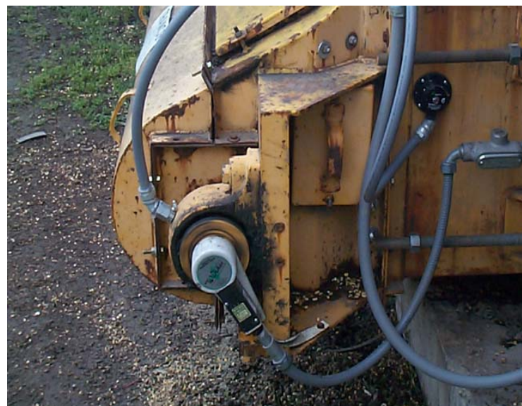
Whirligig installé sur un convoyeur cartérisé avec un contrôleur de rotation M800
